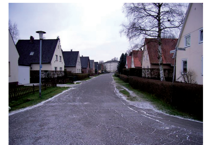
Saniert werden können Mehrfamilienhäuser, aber auch Einfamilienhäuser.
