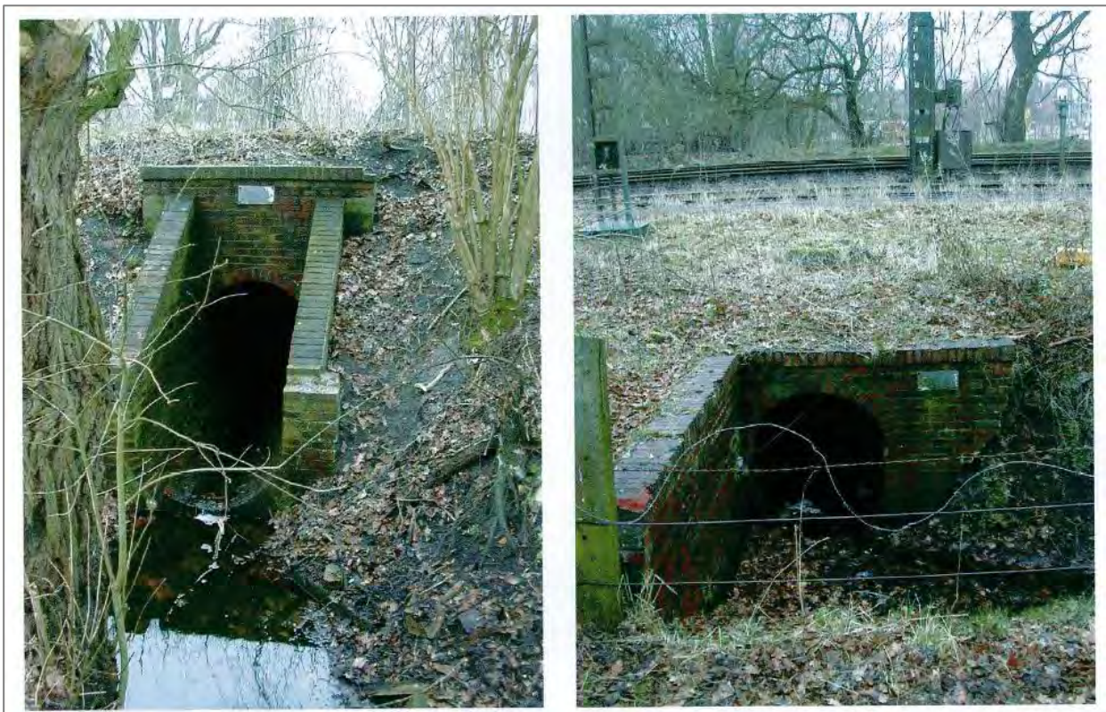
Bild 2.14: Durchlass der Ofenerdieker Bäke unter der Bahntrasse (links Westseite, rechts Ostseite)
