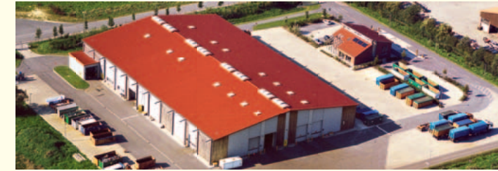
Mechanische Abfallbehandlungsanlage Neuenwege (© OLAR)
