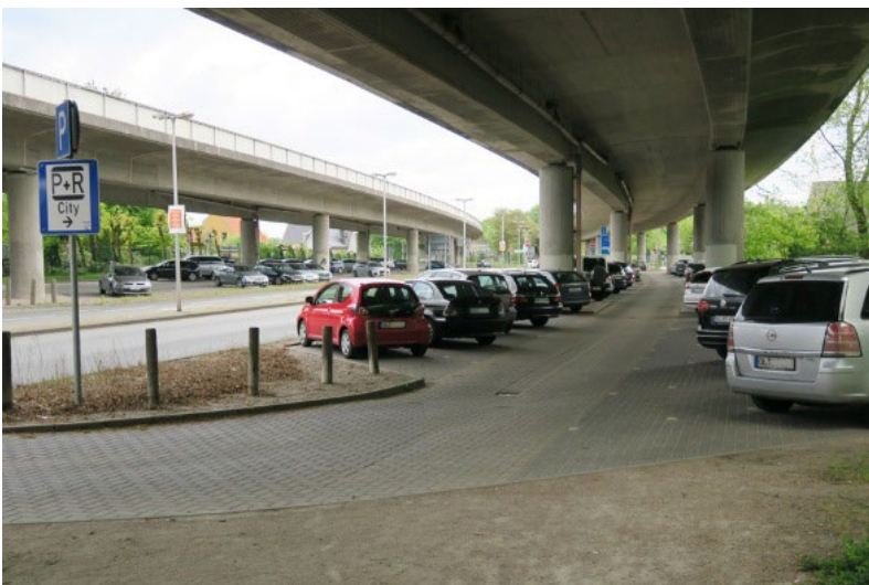
Abbildung 21: P&R-Platz Landwehrstraße an der BAB A28
