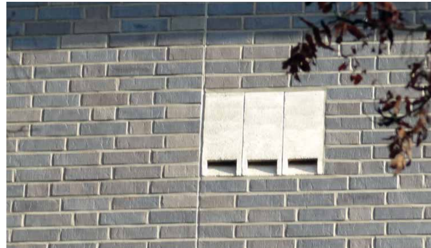
Abbildung 45: Möglichkeiten zur Unterstützung von Fledermäusen ist die Anbringung von Fassadenquartieren wie hier an einem Wissenschaftsgebäude in Oldenburg
