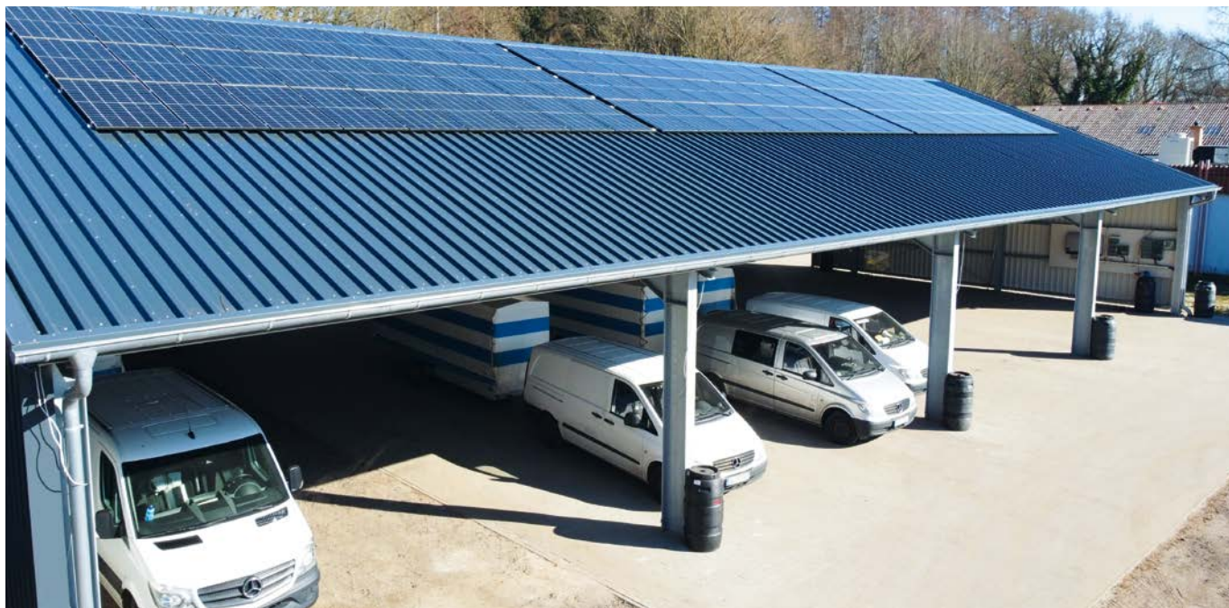
Platz für eine Photovoltaikanlage findet sich fast immer – und sei es auf dem Dach des Fahrzeugunterstands.
