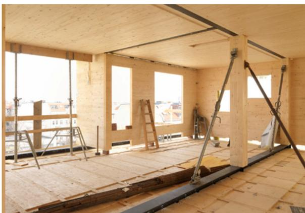
Mehrgeschossiger Hybridbau Hybridkonstruktion (Stahl + Holz) Beispiel: Wohnhaus C13, Hamburg Wilhelmsburg
