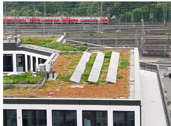
Dachbepflanzung in Kombination mit Photovoltaikanlagen
