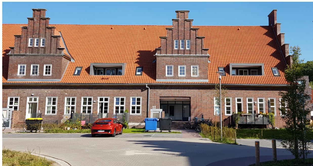
Energetisch ertüchtigte Altbauten auf der Donnerschwee-Kaserne erreichen KfW 70-Standard (Innendämmung, Wärmeschutzverglasung) und schonen Ressourcen (graue Energie)
