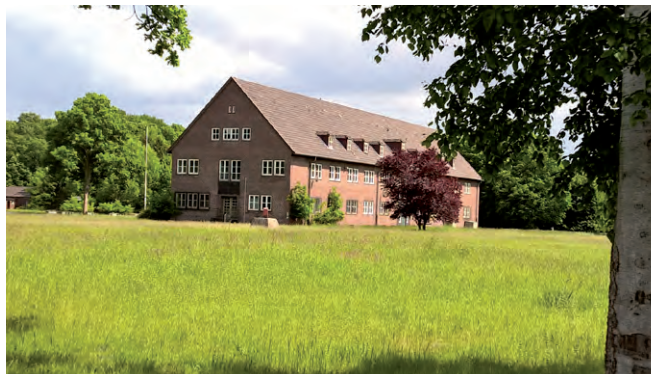
Stabsgebäude von Norden gesehen
