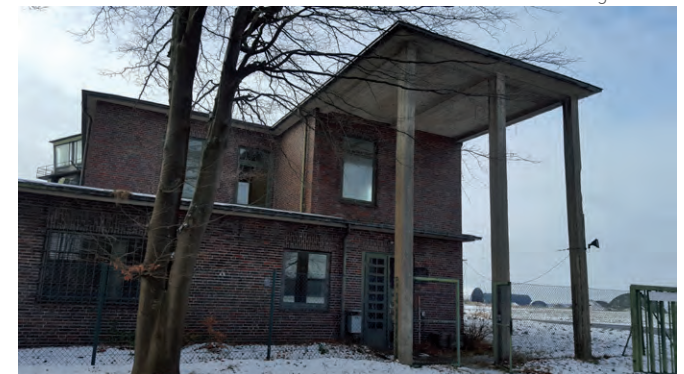
Vordach an der Zufahrt zum Vorfeld
