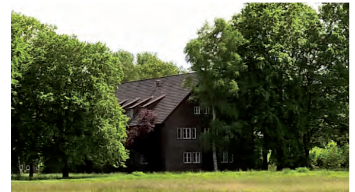
Unterkunftsgebäude von Norden gesehen
