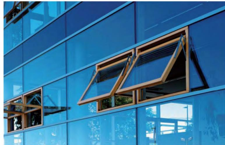
Referenz Pfosten-Riegel-Fassade: nach außen öffnende Fensterelemente (Abbildungen nur für den nicht-öffentlichen Gebrauch!)
