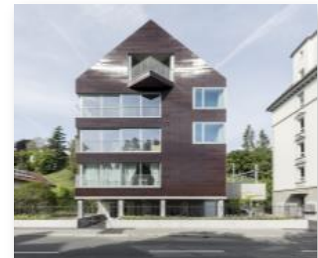
Photovoltaik (Quelle: nfp-energie.ch)
