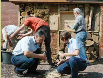
Bau der Stechimmenwand Oldenburg
