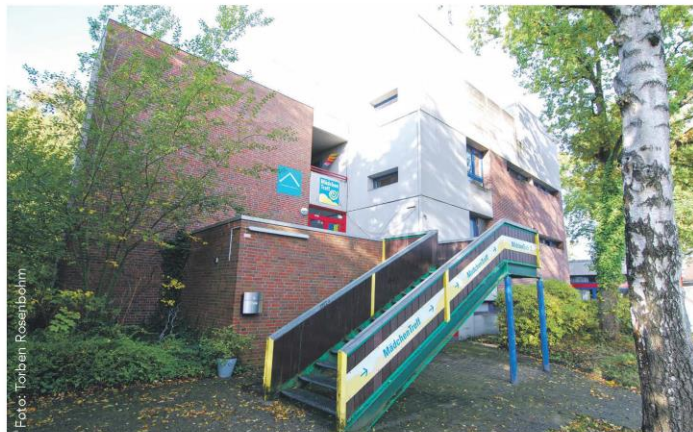
Das Mädchenhaus zieht aus dem Gebäude der ehemaligen Jugendherberge in die Ehernstraße.
