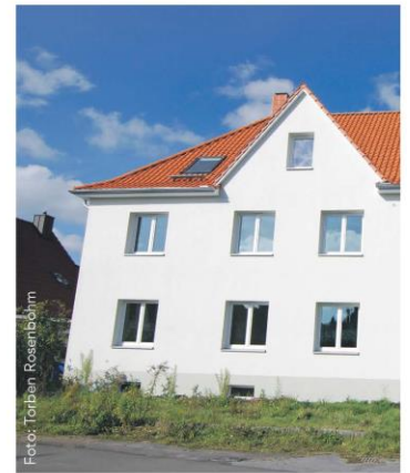
In der Straße am Schießstand entsteht das neue Mädchenhaus.
